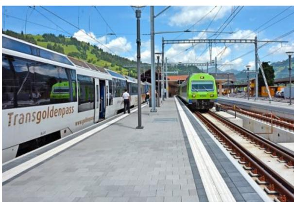
Die Umspuranlage Zweisimmen für den Transgoldpass wird konkret. In den zwei Vierschienengleisen sind die Fundamente dafür schon eingebaut.
